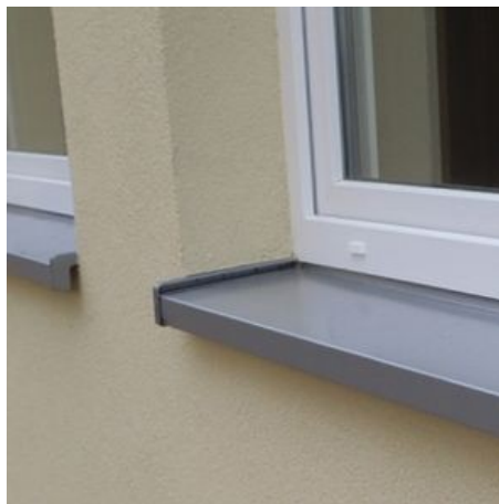
Poprawnie osadzony parapet.
